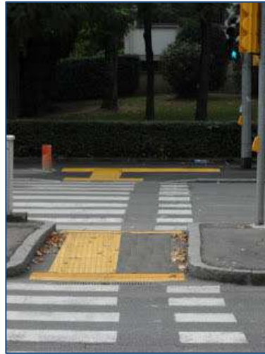
Figura 47 - Esempio di attraversamento pedonale
