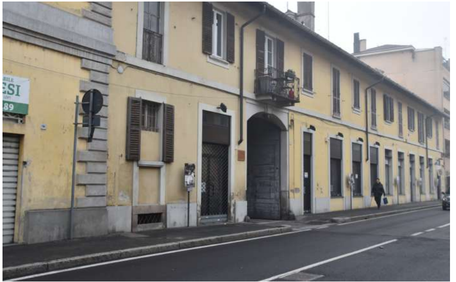
Edificio di valore storico architettonico
