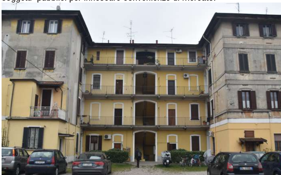
Corte operaia di via San Carlo
