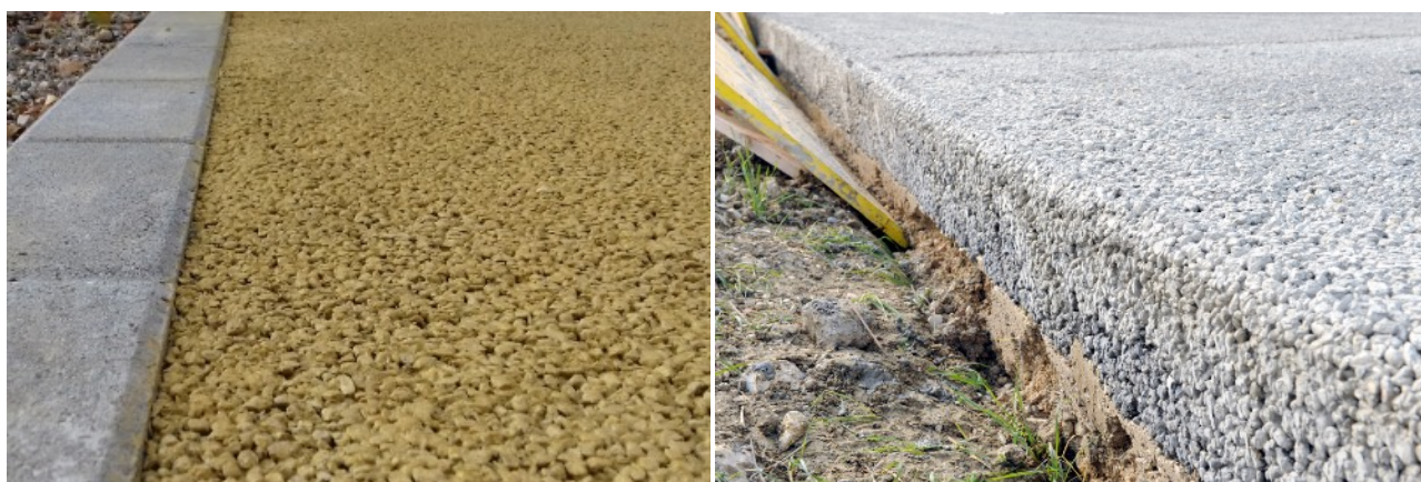
Fig. 4.4: Immagini rappresentative delle pavimentazioni drenanti
