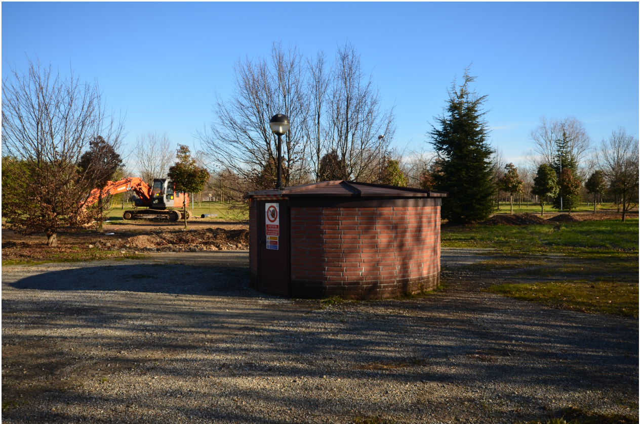
Esempio di mitigazione cameretta avan pozzo priva di interventi di mitigazione.
